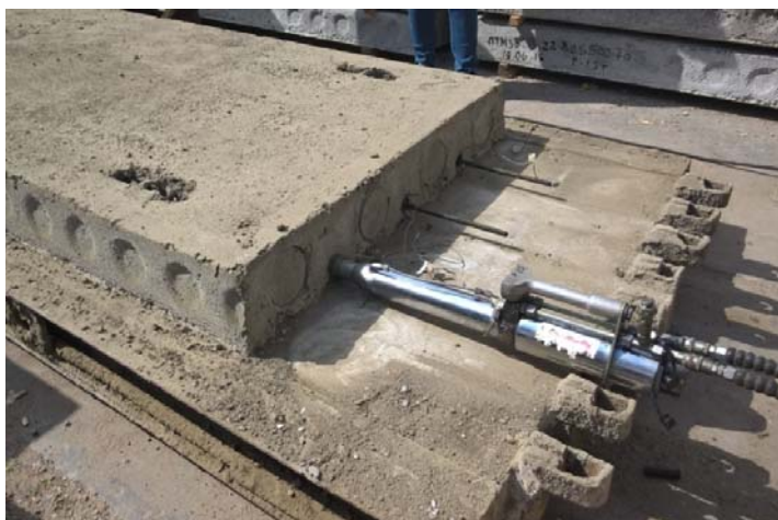
Рисунок 2. – Преднапряжение канатной арматуры экспериментальных плит
