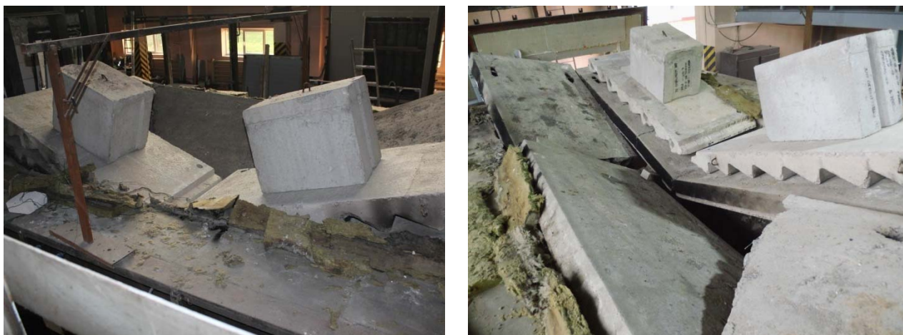
Рисунок 7. – Железобетонные плиты после проведения огневых испытаний
