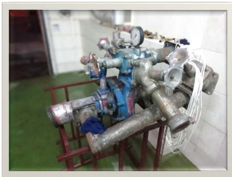
Рисунок 2 – Внешний вид смонтированного стенда перед покраской
